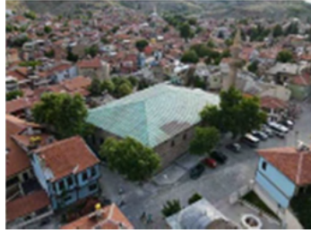
Mevcut bakır kaplama, kırma çatı (KVMGM, 2021)
