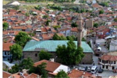
Kuzey cephe niteliksiz yapı temizliği sonrası (VGM Arşivi)
