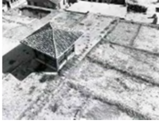
Düz toprak çatı -1947 (VGM Arşivi)
