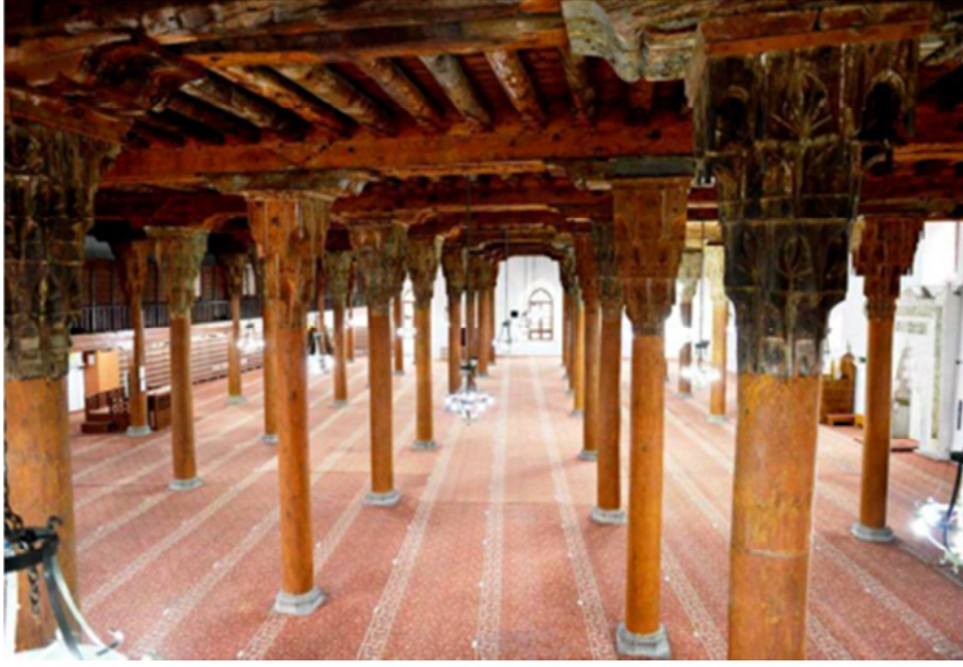
İç Mekan Genel Görünüm (Talip KIZILCA-KTB, 2021)
